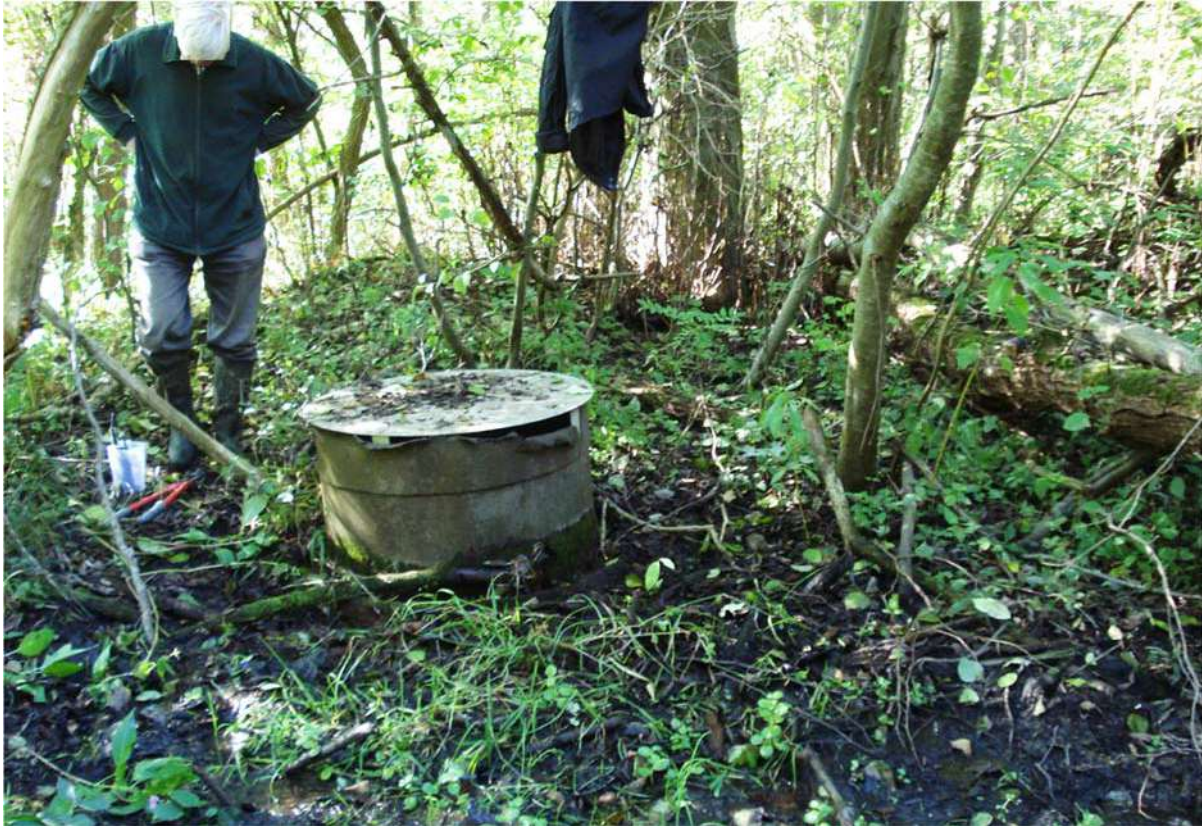
Abbildung 31: Schachtbrunnen im Merklinger Ried
