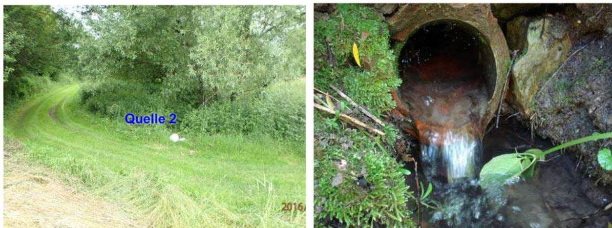
Abbildung 2: Umgebung und Auslauf von Quelle 2 (Austrittshöhe +388,98 m ü. NN [1])
