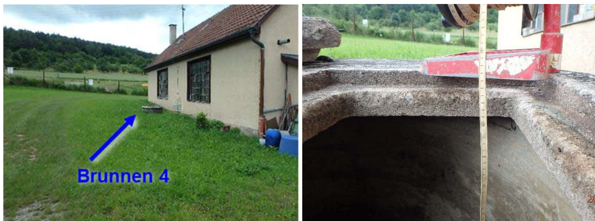
Abbildung 8: Privater Grundwasserbrunnen 4 (Lage siehe Anlage 1)
