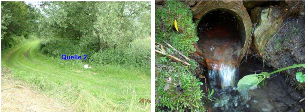
Abbildung 1: Umgebung und Auslauf von Quelle 2 (Austrittshöhe +388,98 m ü. NN [1])
