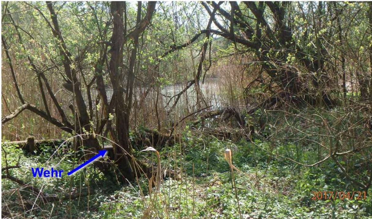
Abbildung 6: Riedsee mit Überlaufwehr (Stauhöhe +385,8 m ü. NN [1])
